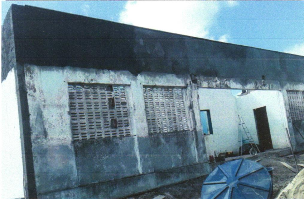
Foto 15 - MASSA ÚNICA, PARA RECEBIMENTO DE PINTURA OU CERÂMICA, ARGAMASSA INDUSTRIALIZADA, PREPARO MECÂNICO, APLICADO COM EQUIPAMENTO DE MISTURA E PROJEÇÃO DE 1,5 M 3 /H EM FACES INTERNAS DE PAREDES, ESPESSURA DE 5MM, SEM EXECUÇÃO DE TALISCAS. AF_06/2014
