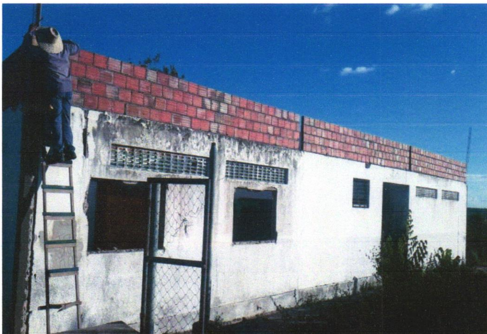
Foto 05- ALVENARIA DE VEDAÇÃO DE BLOCOS CERÂMICOS FURADOS NA HORIZONTAL DE 9X19X29 CM (ESPESSURA 9 CM) E ARGAMASSA DE ASSENTAMENTO COM PREPARO EM BETONEIRA. AF_12/2021
