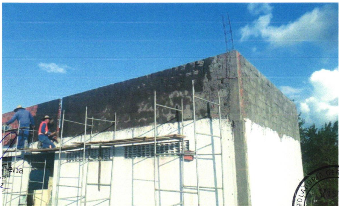
Foto 12 - CHAPISCO APLICADO EM ALVENARIA (COM PRESENÇA DE VÃOS) E ESTRUTURAS DE CONCRETO DE FACHADA, COM EQUIPAMENTO DE PROJEÇÃO. ARGAMASSA TRAÇO 1:3 COM PREPARO EM BETONEIRA 400 L. AF_06/2014
