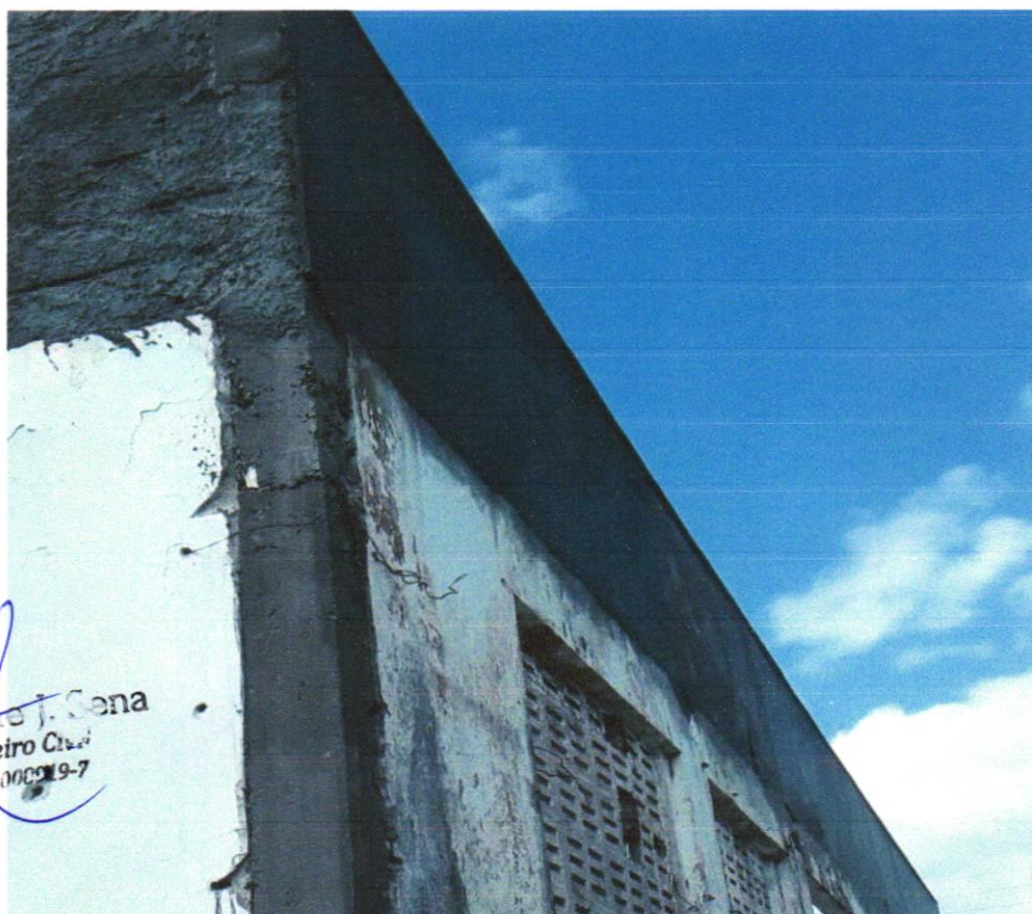
Foto 04 - Chapim de concreto pré-moldado
