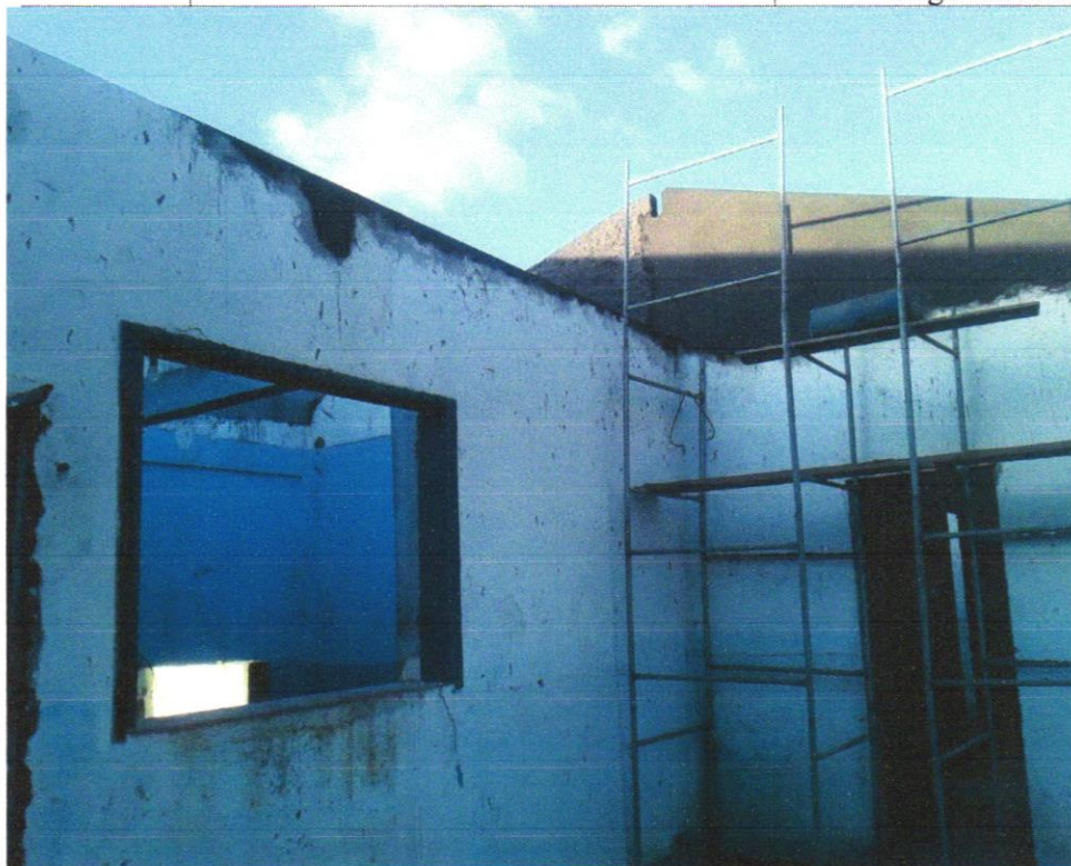
Foto 17 - MASSA ÚNICA, PARA RECEBIMENTO DE PINTURA OU CERÂMICA, ARGAMASSA INDUSTRIALIZADA, PREPARO MECÂNICO, APLICADO COM EQUIPAMENTO DE MISTURA E PROJEÇÃO DE 1,5 M3/H EM FACES INTERNAS DE PAREDES, ESPESSURA DE 5MM, SEM EXECUÇÃO DE TALISCAS. AF_06/2014
