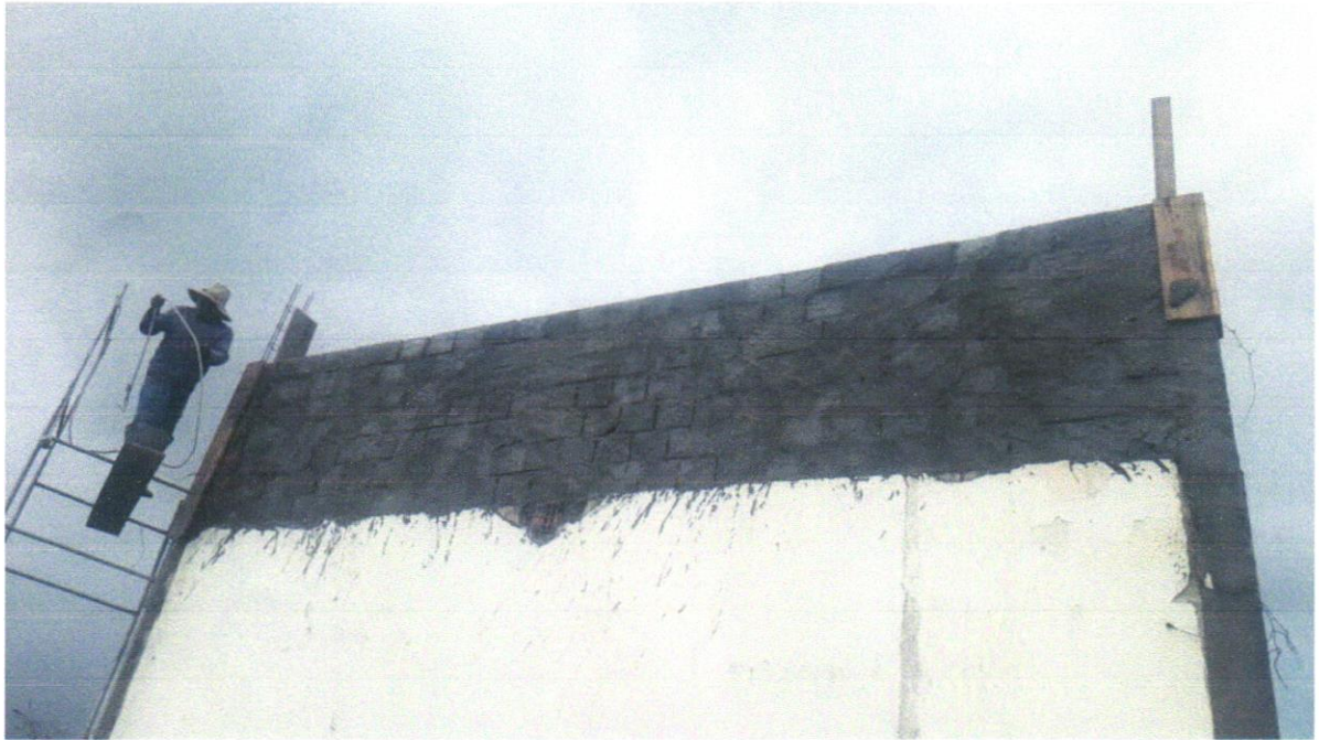
Foto 11 - CHAPISCO APLICADO EM ALVENARIA (COM PRESENÇA DE VÃOS) E ESTRUTURAS DE CONCRETO DE FACHADA, COM EQUIPAMENTO DE PROJEÇÃO. ARGAMASSA TRAÇO 1:3 COM PREPARO EM BETONEIRA 400 L. AF_06/2014
