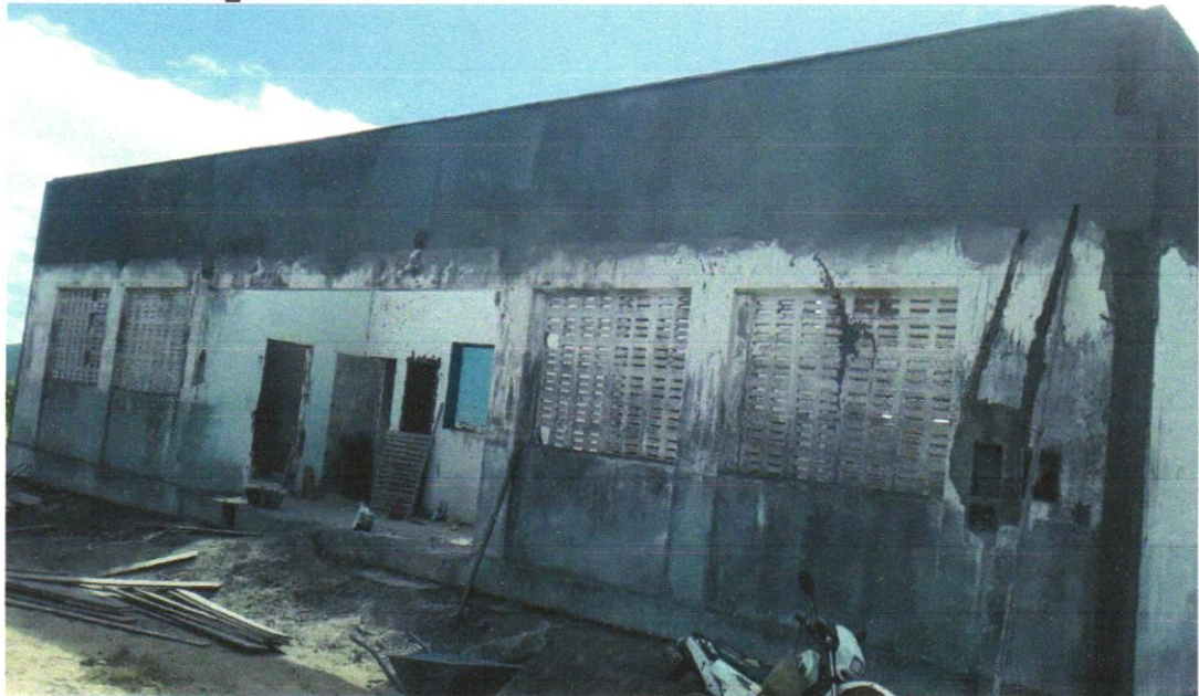
Foto 14 - MASSA ÚNICA, PARA RECEBIMENTO DE PINTURA OU CERÂMICA, ARGAMASSA INDUSTRIALIZADA, PREPARO MECÂNICO, APLICADO COM EQUIPAMENTO DE MISTURA E PROJEÇÃO DE 1,5 M 3 /H EM FACES INTERNAS DE PAREDES, ESPESSURA DE 5MM, SEM EXECUÇÃO DE TALISCAS. AF_06/2014
