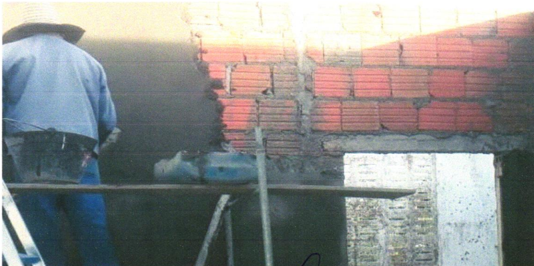
Foto 08 - VERGA PRÉ-MOLDADA PARA JANELAS COM ATÉ 1,5 M DE VÃO. AF_03/2016
